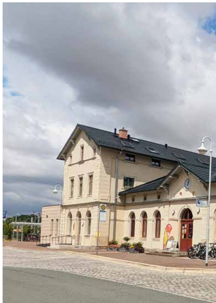
Aus dem Jahr 1880 stammt das Bahnhofsgebäude in Oschatz.
